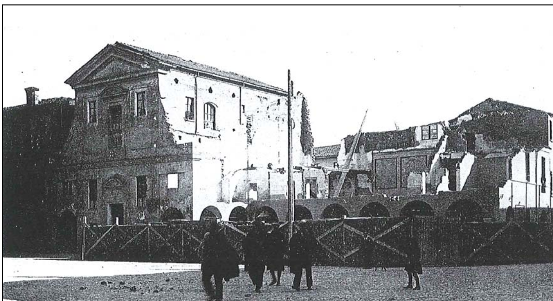
Immagine degli anni '30, dove si vedono i lavori di demolizione in corso del complesso ospedaliero (Cappi V. 1973, op. cit. pg. 152)
