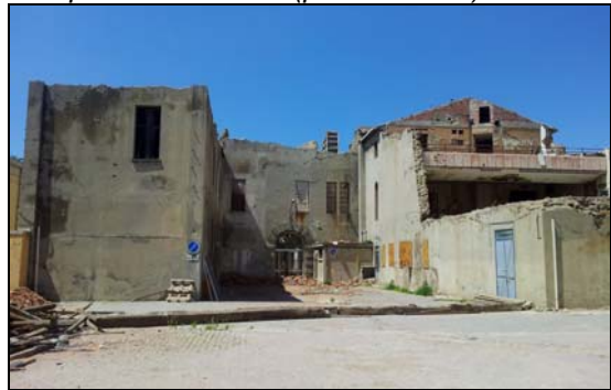
Cortile interno (porzione sud)
