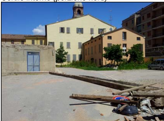
Fabbricati affacciati su via Roma
