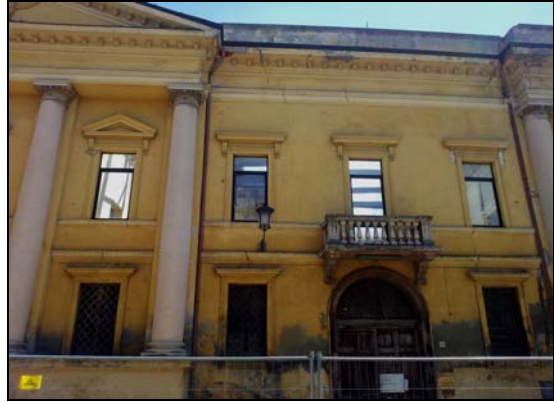
Prospetto su via Pico (porzione sud)
