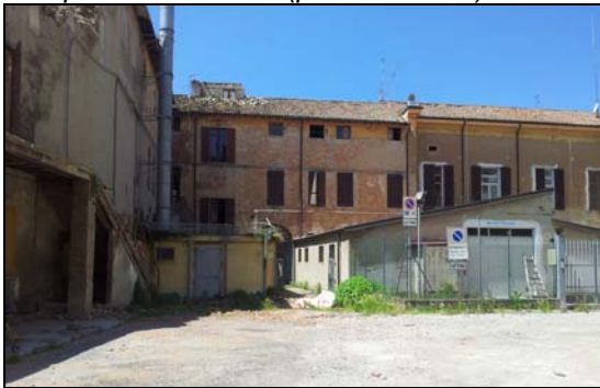
Cortile interno (porzione nord)
