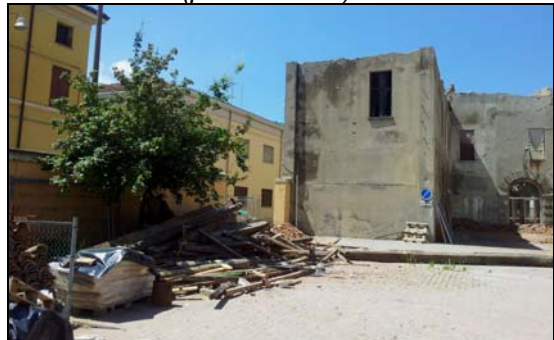
Cortile interno (porzione sud)
