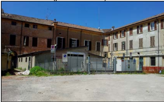
Cortile interno (porzione nord)
