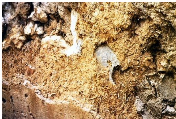
Lacerto di intonaco in terra cruda e paglia ricoperto successivamente da intonaco di calce
