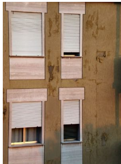
PASSAGGIO DEL VAPORE D'ACQUA ATTRAVERSO UN MURO CON RIVESTIMENTO PROTETTIVO NON TRASPIRANTE
