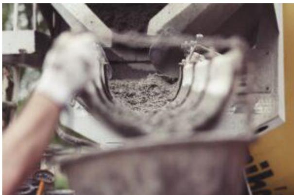
Il cemento e il calcestruzzo sono fondamentali nell'edilizia globale, ma il cemento Portland, ampiamente utilizzato, consuma grandi quantità di energia e materie prime, emettendo CO<sub>2</sub>, che contribuisce al riscaldamento globale. Per ridurre queste emissioni, si utilizzano materiali di scarto industriali e naturali come ceneri volanti, metacaolino e scorie d'altoforno granulate, creando cementi ecologici e a basse emissioni di CO<sub>2</sub>.
