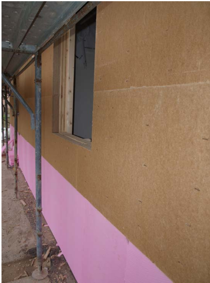
Primi 60 cm. del cappotto eseguiti con polistirene estruso a protezione basamento
