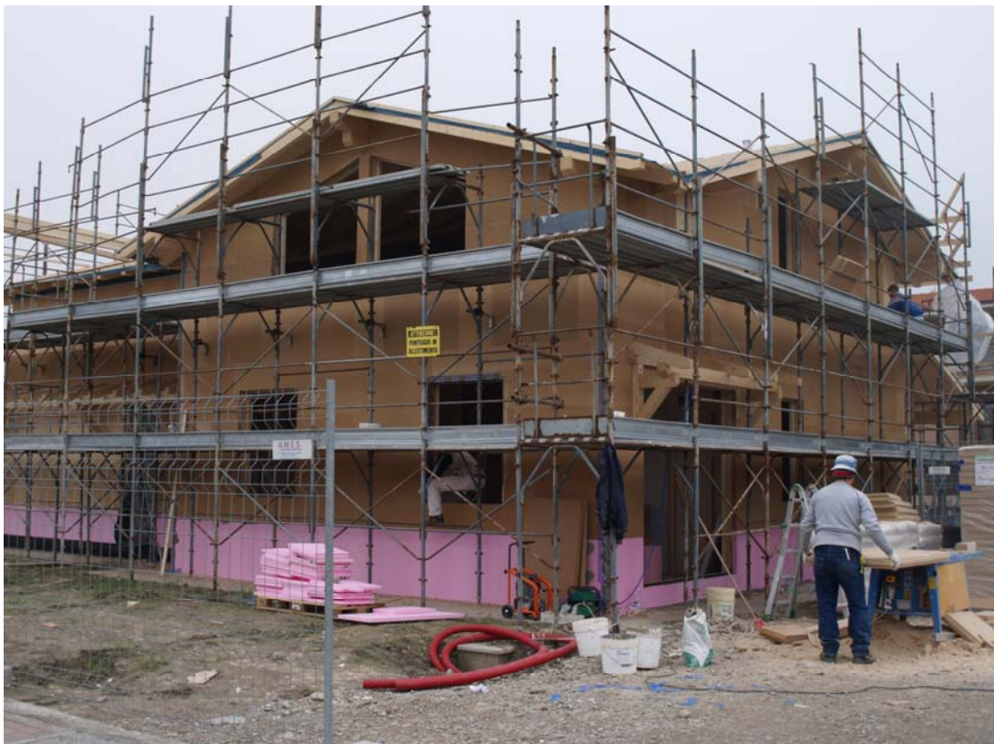
Posa cappotto esterno in fibra di legno spessore cm. 8
