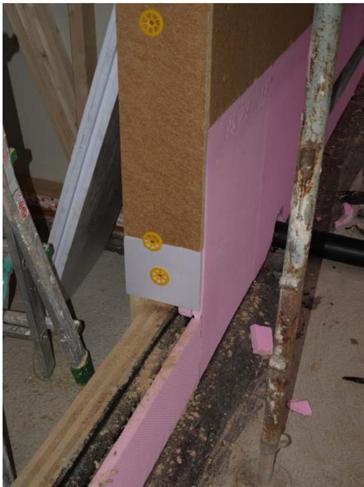
Primi 60 cm. del cappotto eseguiti con polistirene estruso a protezione basamento
