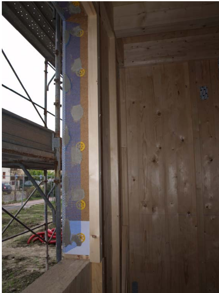
Particolare spalle finestre con paraspigolo
