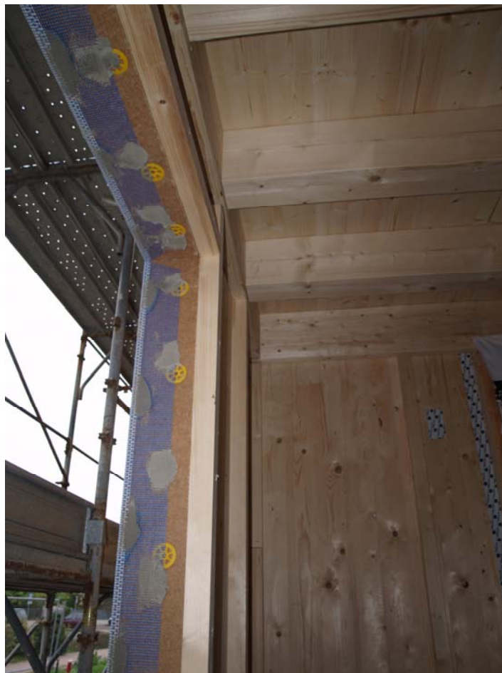
Particolare spalle finestre con paraspigolo
