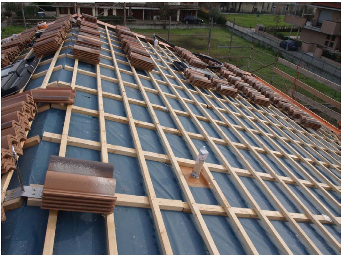
Inizio posa tegole, in primo piano predisposizione per linea vita
