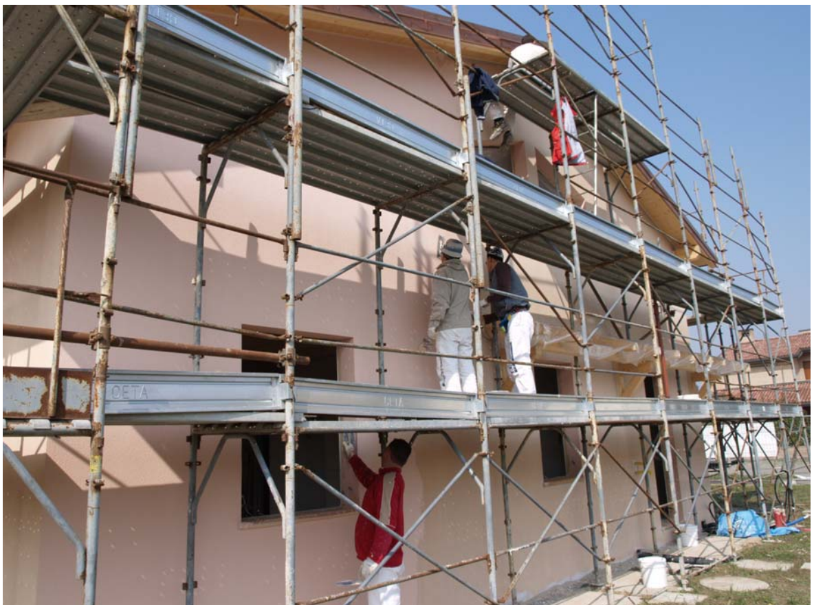
Posa dell'intonachino colorato
