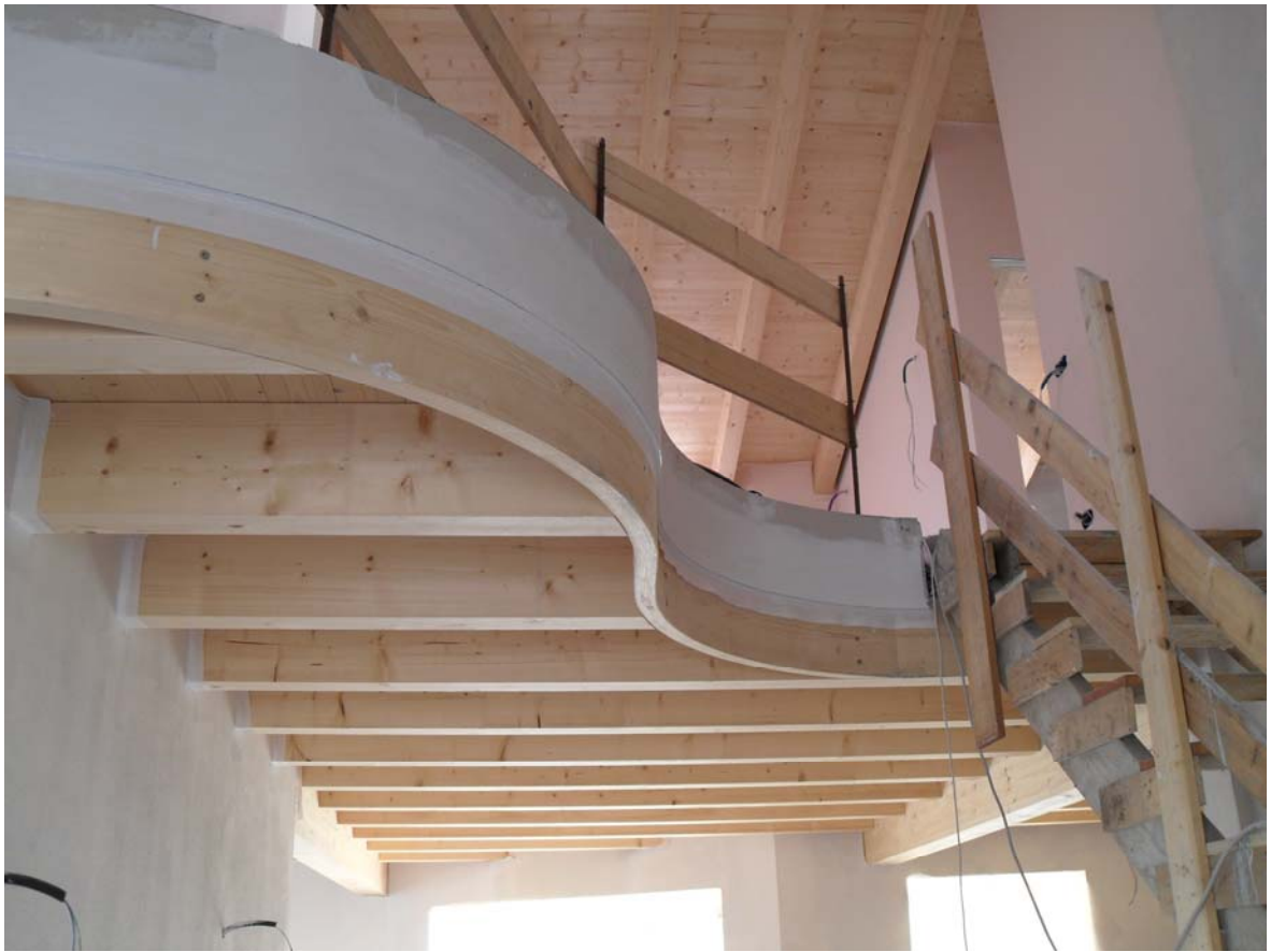
Viste interne delle pareti in fase di completamento
