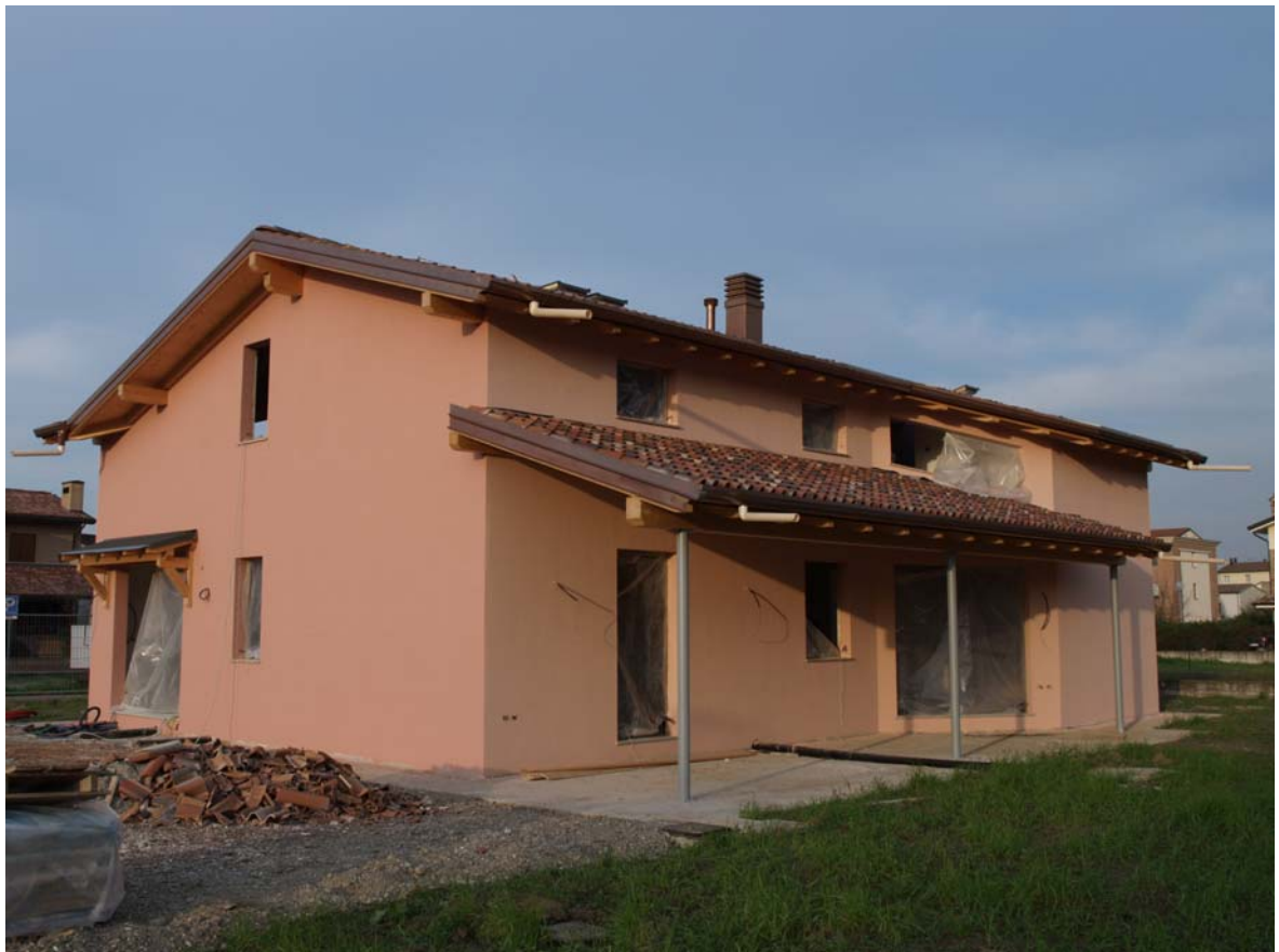
Viste esterne a intonachino terminato e ponteggio smontato
