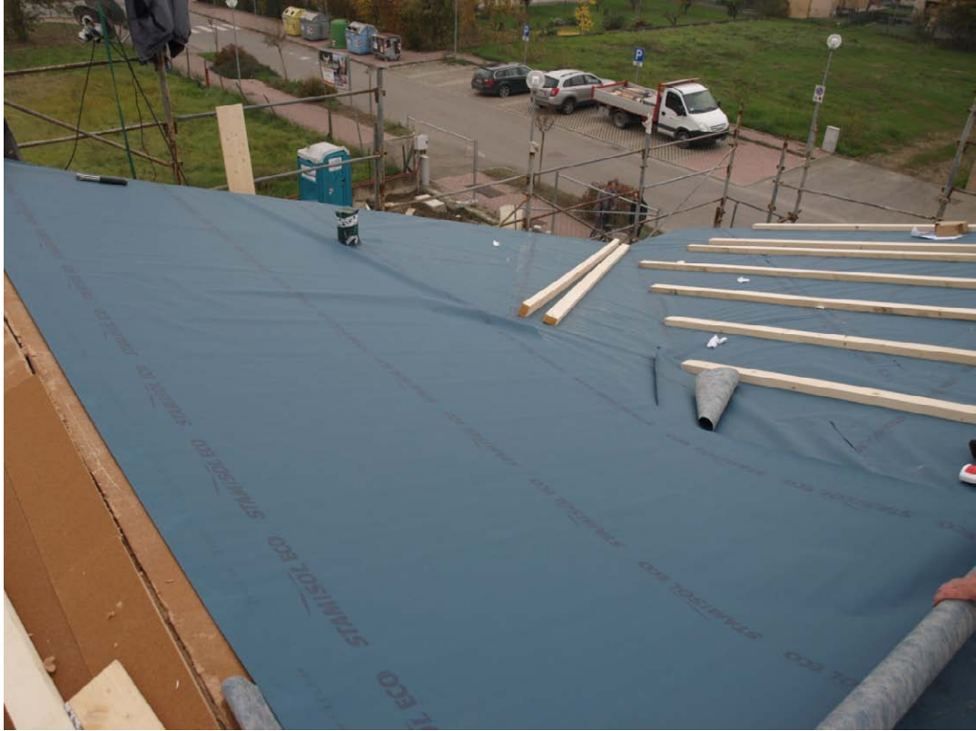
Posa del secondo telo traspirante Stamisol Eco, con giunzioni incollate
