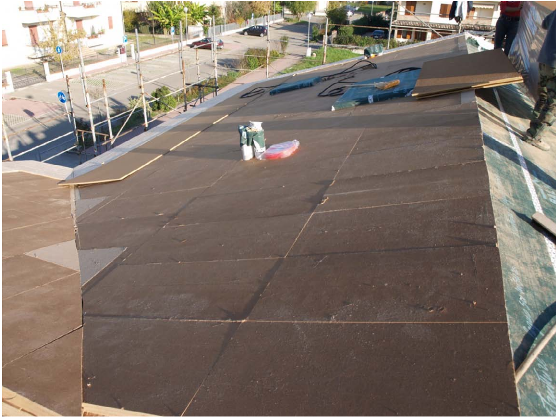
Posa del pacchetto di isolamento in copertura (16 cm. Fibra di legno)
