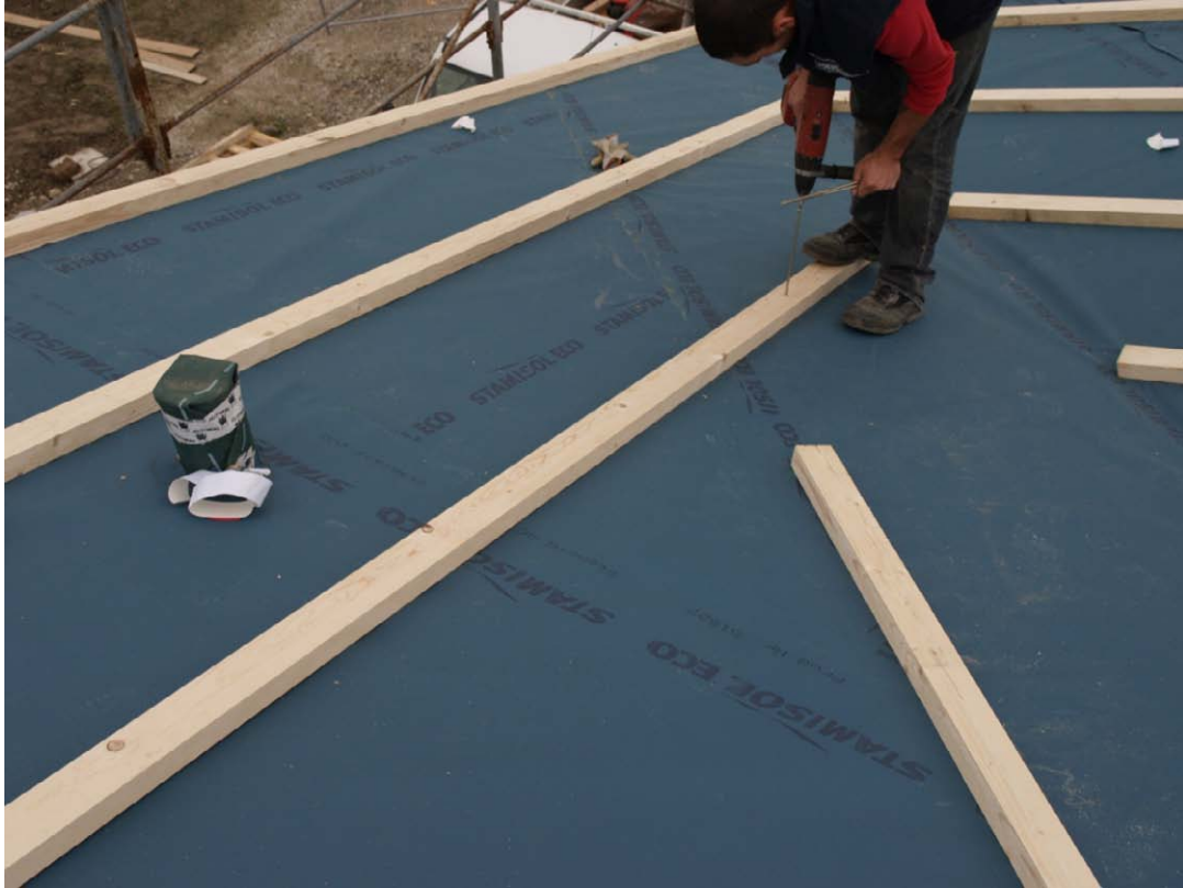
Posa listellatura di ventilazione
