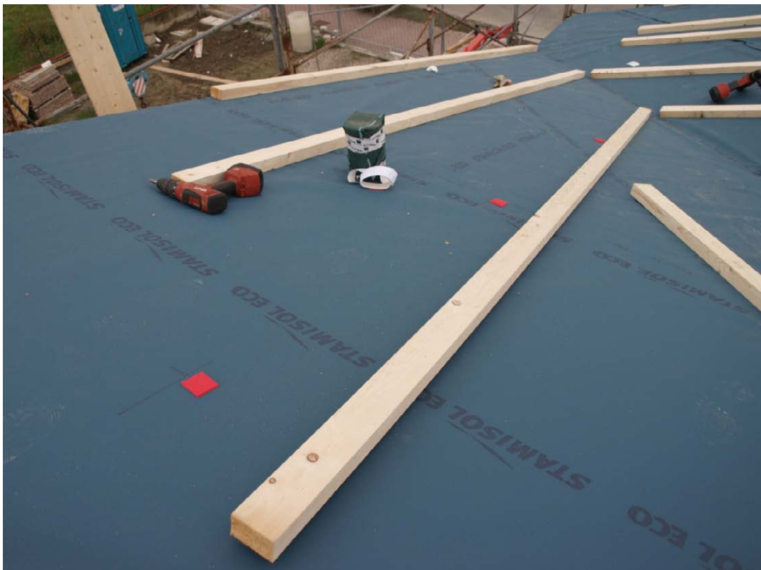
Posa guarnizioni di tenuta per listelli di ventilazione
