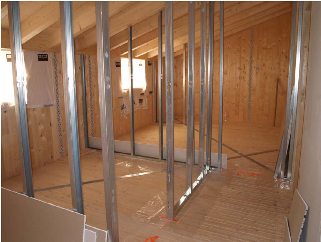
Posa della struttura in acciaio per le pareti interne non portanti con doppia lastra per lato in cartongesso
