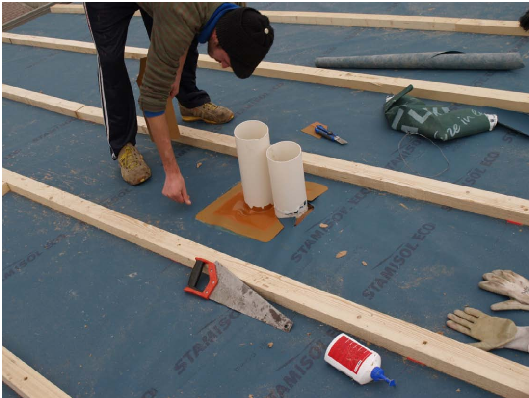
Posa elementi di raccordo a tenuta per sfiati
