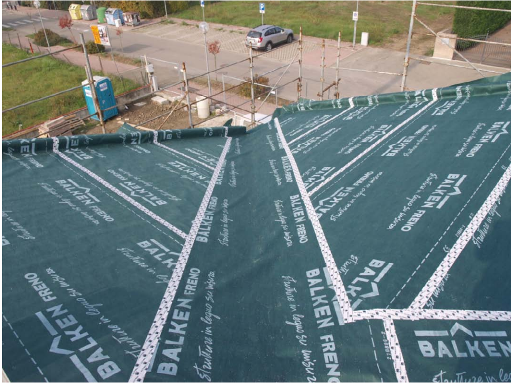
Freno vapore con nastratura delle giunzioni
