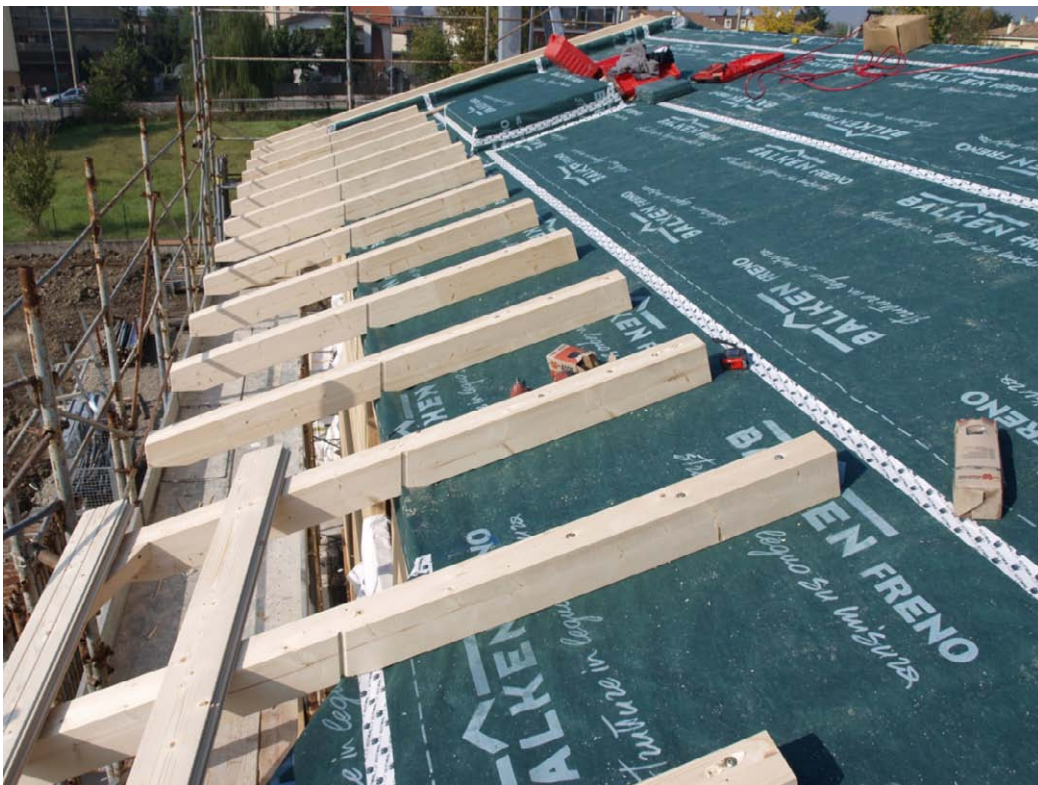
Posa dei travetti di sporgenza con sistema doppio tetto
