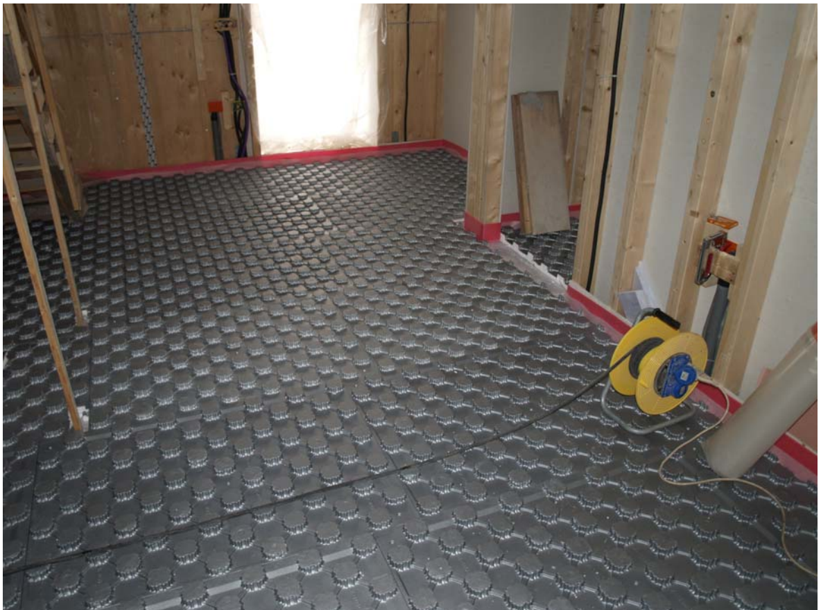
Posa del pannello per impianto radiante a pavimento
