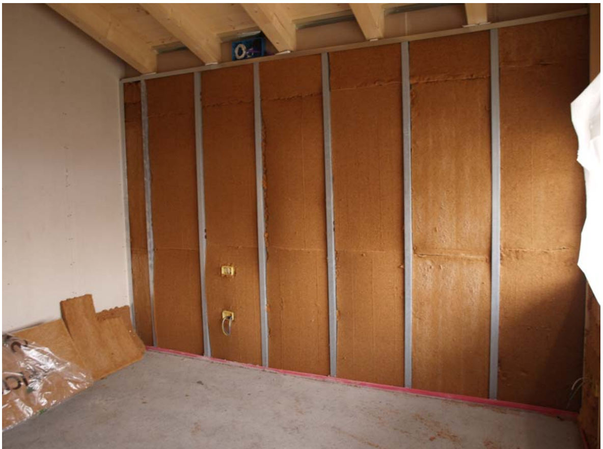
Posa del materassino in fibra di legno all'interno delle pareti interne e contropareti esterne
