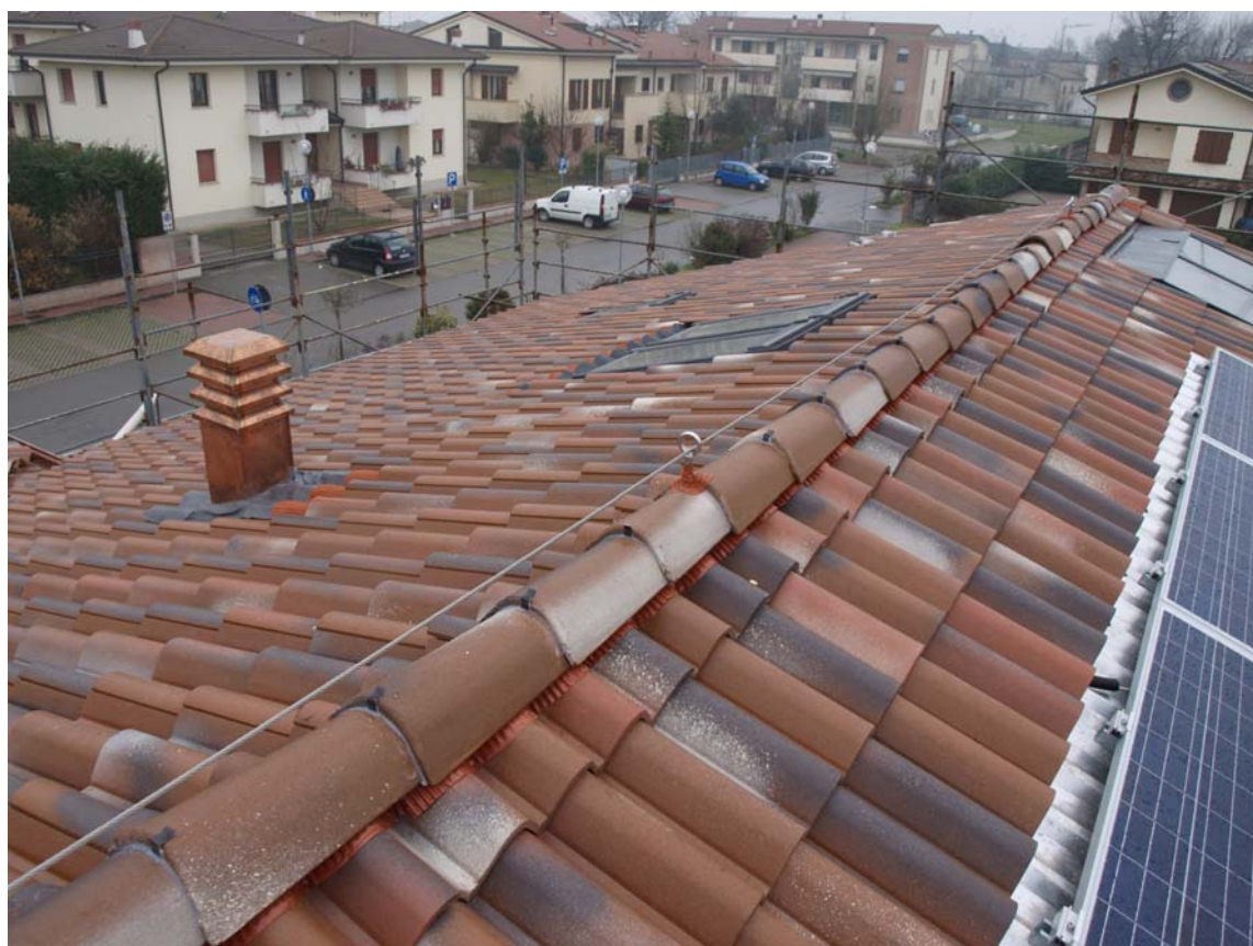
Particolare della linea vita in copertura
