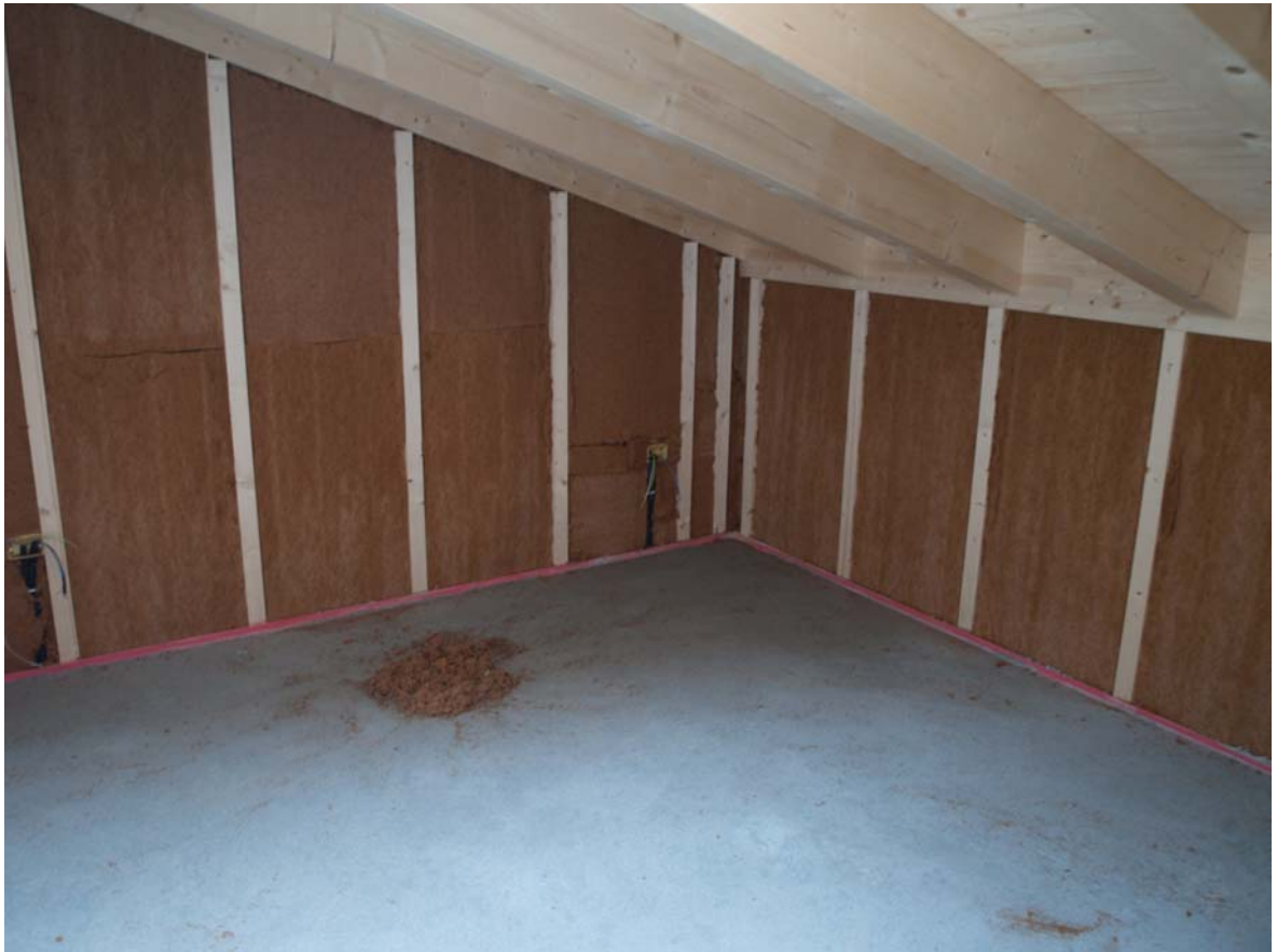
Posa del materassino in fibra di legno all'interno delle pareti interne e contropareti esterne
