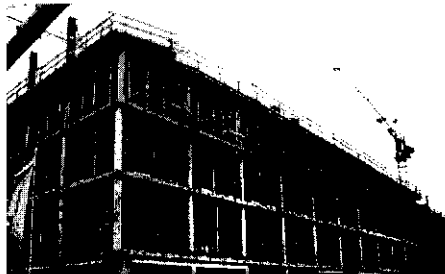
Fig. 9.2.4-1 Esempio di utilizzo di un sistema T (costruzione di edifici)
