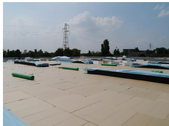
Esempio di tetto caldo con POLIISO PLUS
